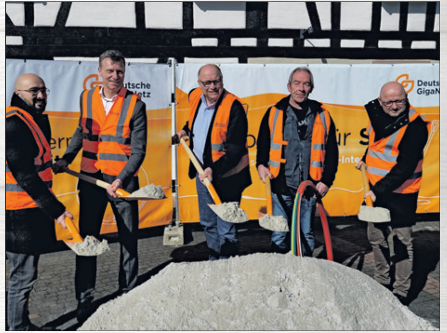
Symbolischer Spatenstich in Münster – der Glasfaserausbau in Kelkheim beginnt. Foto: Archiv
