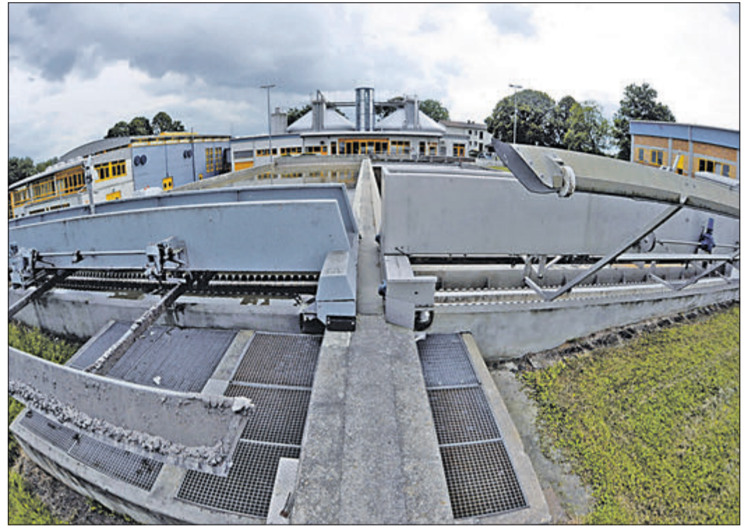
Investitionen zwischen sechs und knapp zehn Millionen Euro stehen bis 2020 für die notwendigen Sanierungsmaßnahmen an der Kläranlage an.
