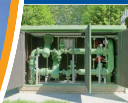
Gasdruckregelanlage (GDR)
