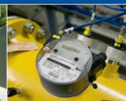
Turbinenrad-Gaszähler (TRZ)
