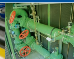
Gasdruckregelmessanlage (GDRM)
