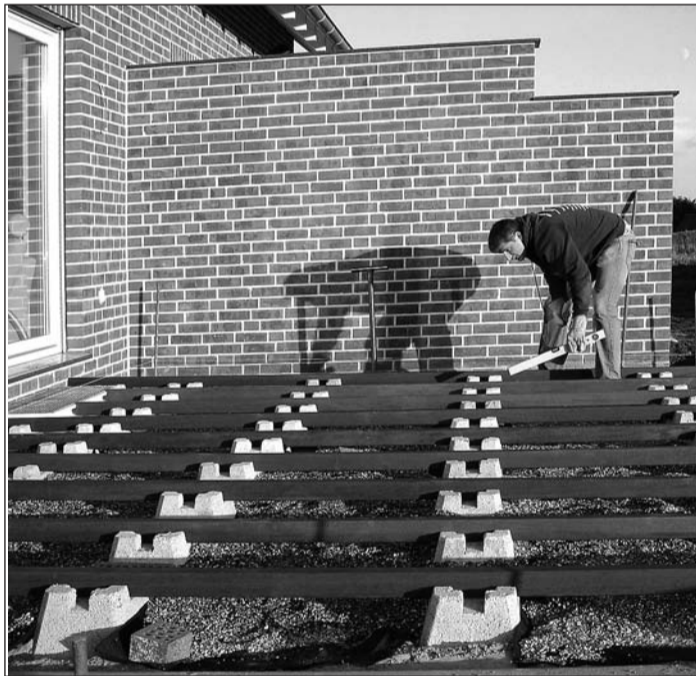
Ips/Du. Mit neuen Fundamentsteinen lassen sich Holzterrassen schnell und leicht in Eigenregie errichten. Foto: Brinkmann
