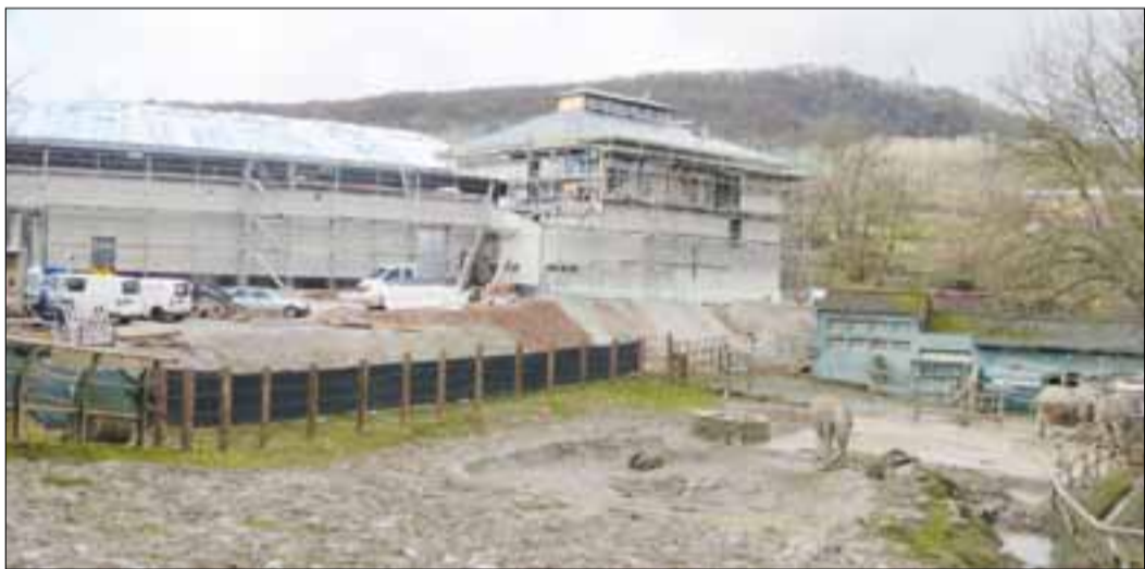
10,4 Millionen Euro kostet das neue Elefantendomizil mit 800 Quadratmeter großer Lauffläche und integrierter Restauration. Foto: Opel-Zoo
