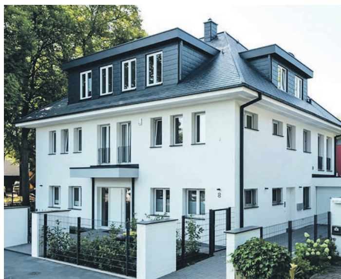
Kleine Elemente wie Dachrinnen und Fallrohre oder die Verkleidungen von Mauerabschlüssen beeinflussen die Gesamtwirkung einer Hausfassade.
