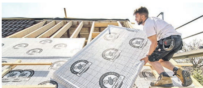
Energie sparen und das Raumklima verbessern: Eine nachträgliche Dämmung des Dachs trägt in älteren Gebäuden wesentlich zu mehr Energieeffizienz bei. Foto: DJD/Paul Bauder/www.michaelgallner.com
