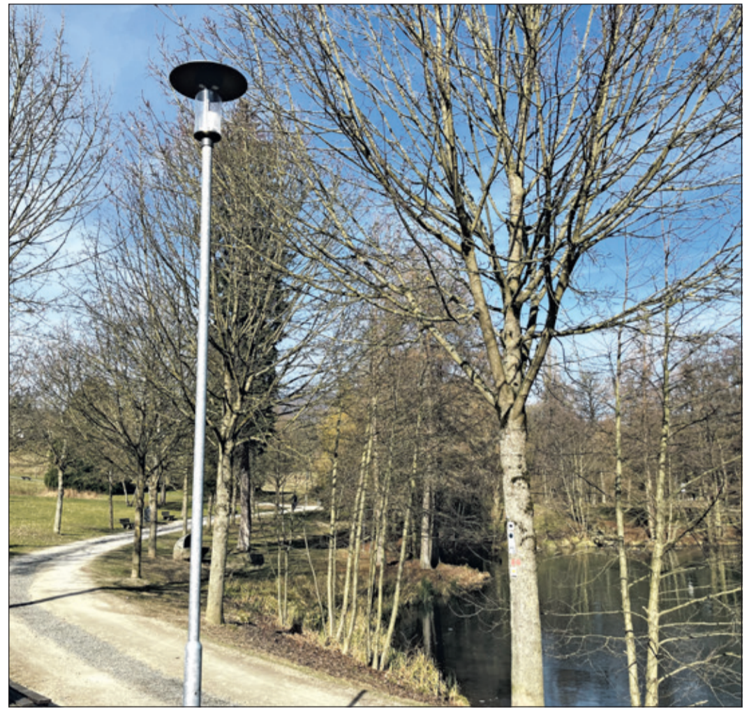
Im Viktoriapark sorgen mit LED-Technik ausgestattete Lampen für eine effiziente Beleuchtung.
