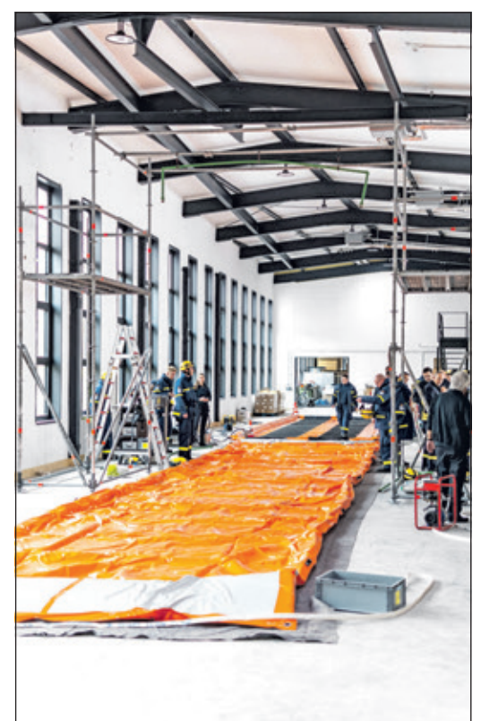
Im Katastrophenschutzlager des Hochtaunuskreises wird die Schleuse fachgerecht aufgebaut. Im Ernstfall wird die Wanne mit Desinfektionsmittel gefüllt. Foto: Hochtaunuskreis
