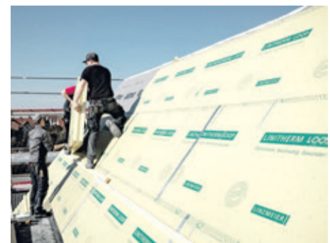
WLS 023: UNITHERM LOOP verfügt über die geringste Wärmeleitfähigkeit aller derzeit auf dem Markt erhältlichen biobasierten Dämmstoffe. (Foto: epr/Linzmeier)
