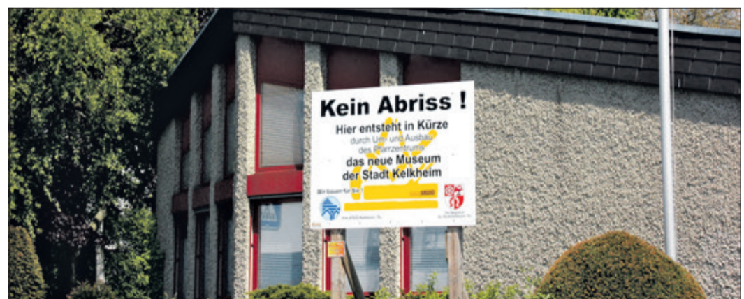
2018 kam es zum Bürgerbescheid, der ergab, dass das ehemalige Pfarrzentrum zum Museum umgebaut werden soll. Sieben Jahre später hat die Politik jetzt anders entschieden. Das Pfarrzentrum wird abgerissen und macht einem Mehrgenerationenhaus Platz. Foto: ph
