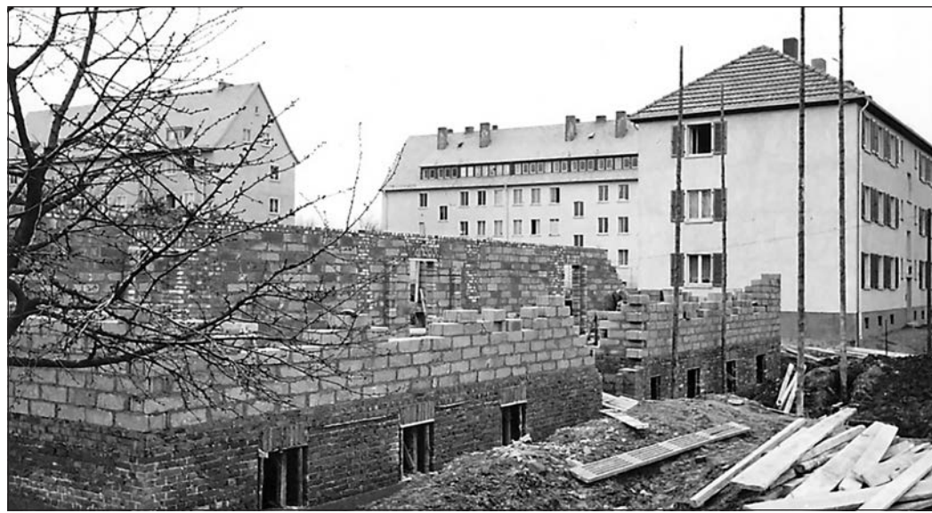
Eine Baustelle der Genossenschaft 1952 in der Jacobistraße.
