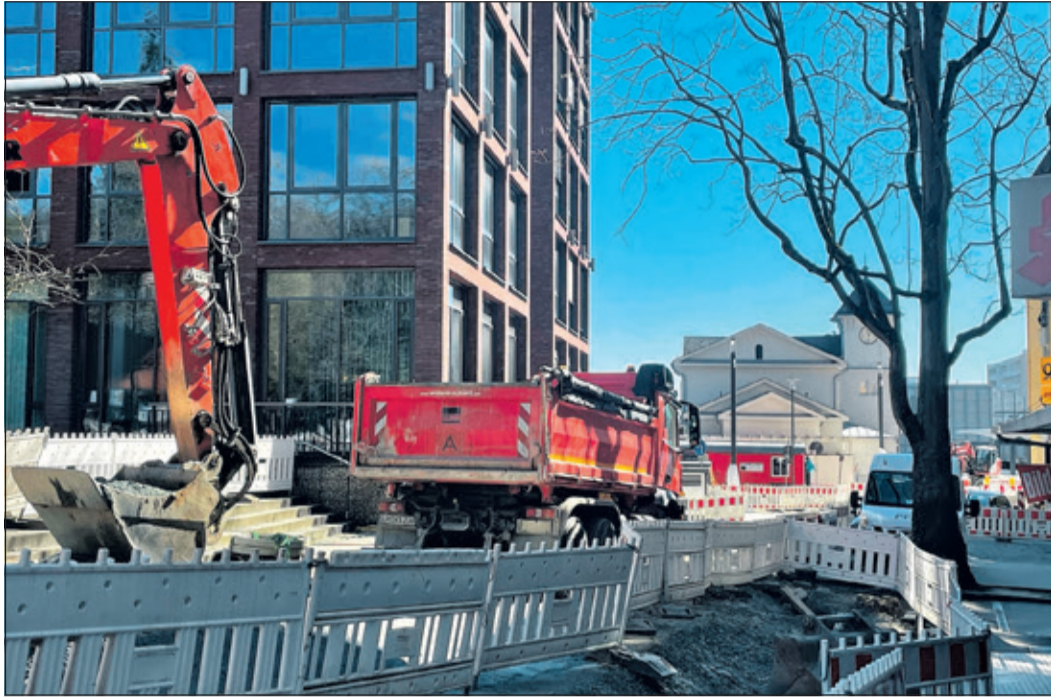
Fußgänger kommen immer noch an der Baustelle in der Straße Am Bahnhof.
