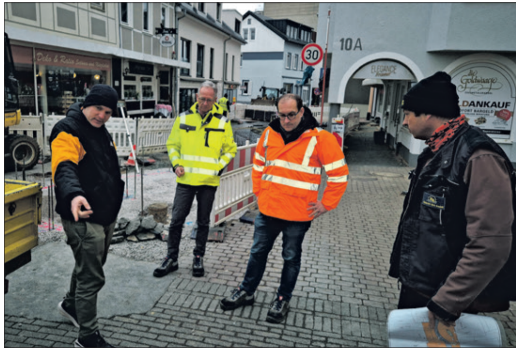
Ingo Hartmann (l.) von der städtischen Abteilung Tiefbau und Heilquellen erläutert Fachbereichsleiter Michael Serba (2.v.l.) und Bürgermeister Dr. Frank Blasch die Verlegung der unterschiedlichen Pflasterarten. Rechts ein Mitarbeiter der bauausführenden Firma.
