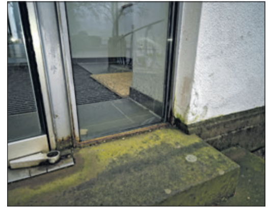
Demnächst beginnt die Sanierung der Windfänge am Kulturzentrum Badehaus.
