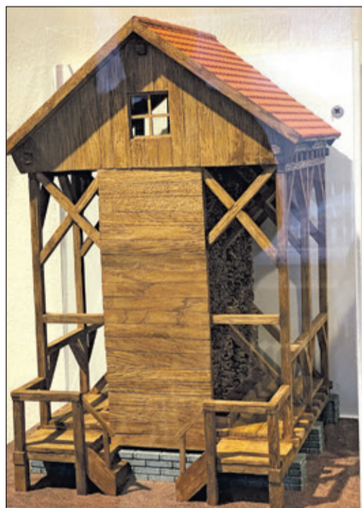
Das Modell eines Gradierwerkes. Die Wände waren mit Schwarzdornzweigen bestückt, über die das salzhaltige Quellwasser (Sole) gepumpt wurde.
