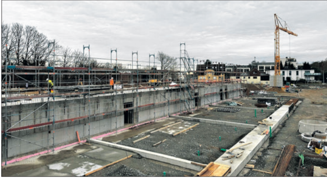
Zahlreiche Projekte wie der Neubau der Feuerwache können jetzt planmäßig weiter umgesetzt werden.
