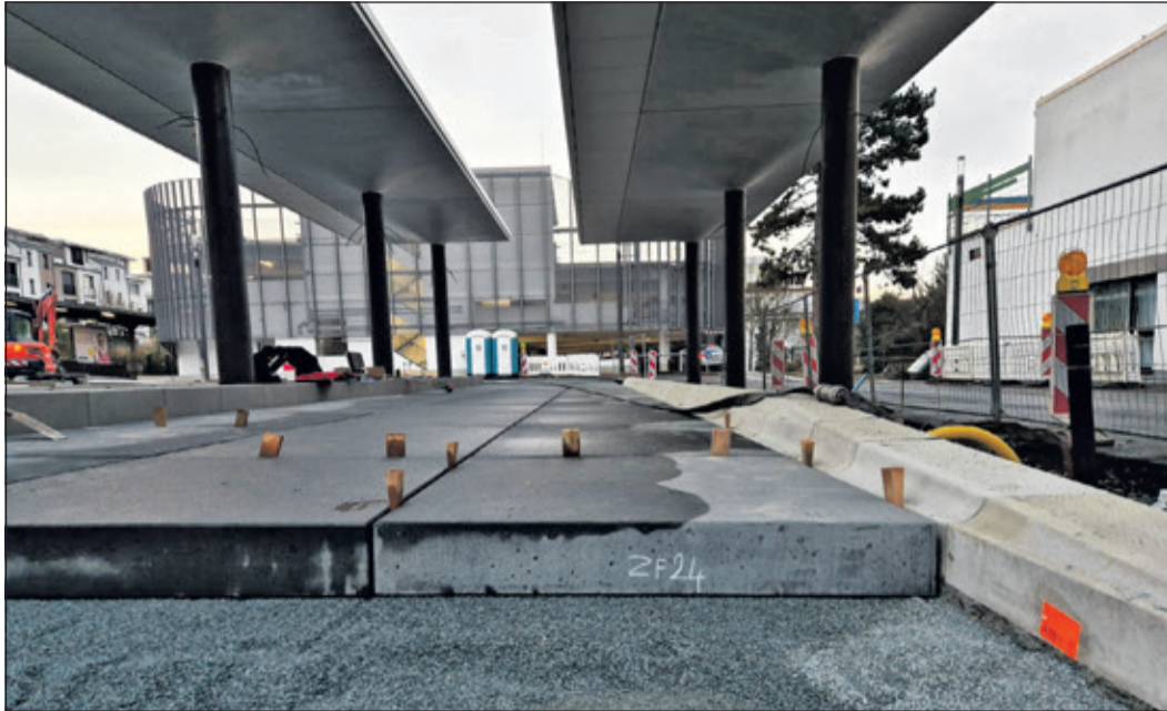
Unten die Schwerlastplatten, oben das fertige Dach: Blick auf die Arbeiten am ZOB in der Vorweihnachtswoche. Foto: Stadt Bad Soden
