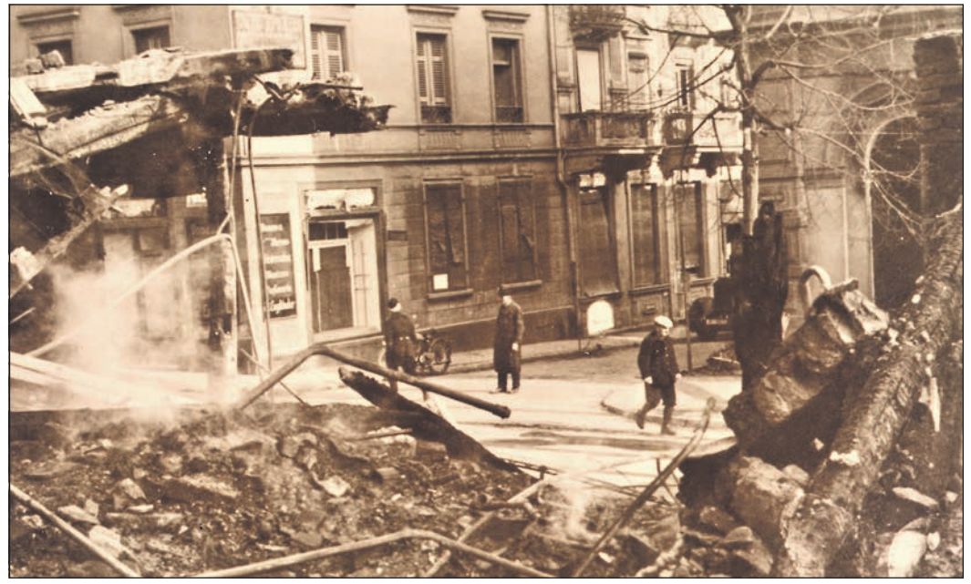
Nach dem Bombenangriff wird das Ausmaß der Zerstörung sichtbar. 34 Bad Homburger starben und 188 Wohnungen wurden zerstört. Repro: Stadtarchiv
