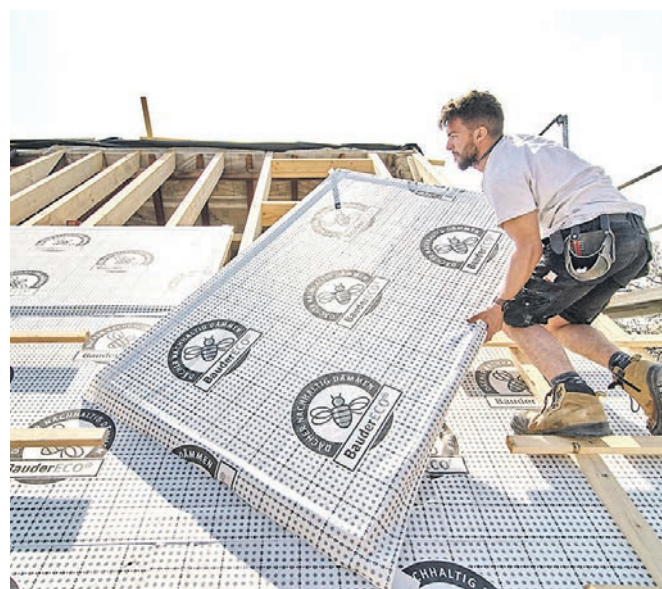
Energie sparen und das Raumklima verbessern: Eine nachträgliche Dämmung des Dachs trägt in älteren Gebäuden wesentlich zu mehr Energieeffizienz bei.
