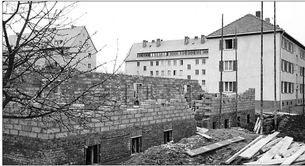
Eine Baustelle der Genossenschaft 1952 in der Jacobistraße.
