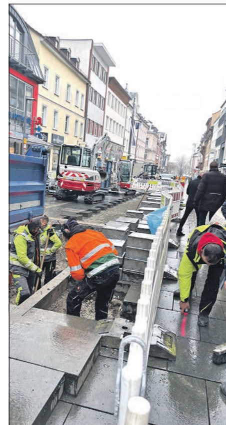
Der zweite Bauabschnitt auf der Louisenstraße hat begonnen. Foto: Stadt
