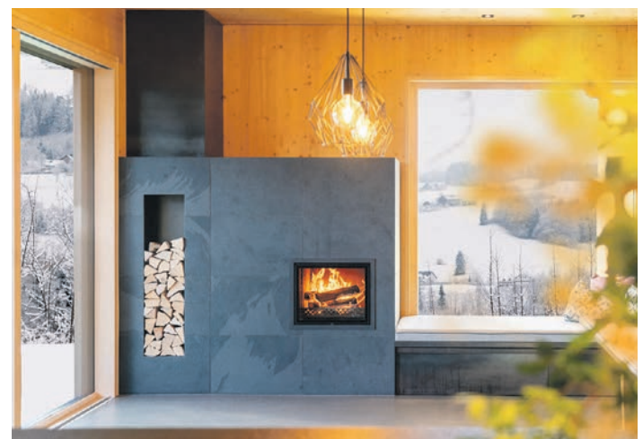
Holzfeuerstätten wie Speichergrundöfen mit Wasserwärmetauscher können auch eine Wärmepumpe ideal ergänzen und entlasten.
