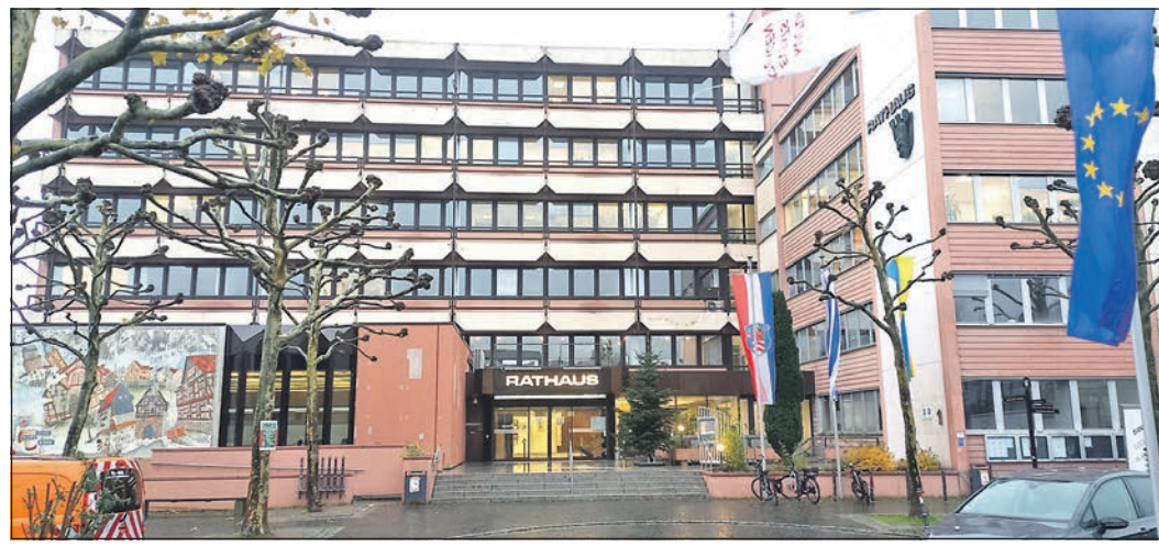
Noch kreist der Pleitegeier nicht über dem Dach des Rathauses. Wie es mit dem maroden Rathaus weitergeht, ist allerdings noch immer nicht entschieden. Foto: js
