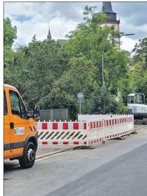
Die Vorarbeiten für Baumpflanzungen in der Portstraße haben begonnen. Foto: Stadt
