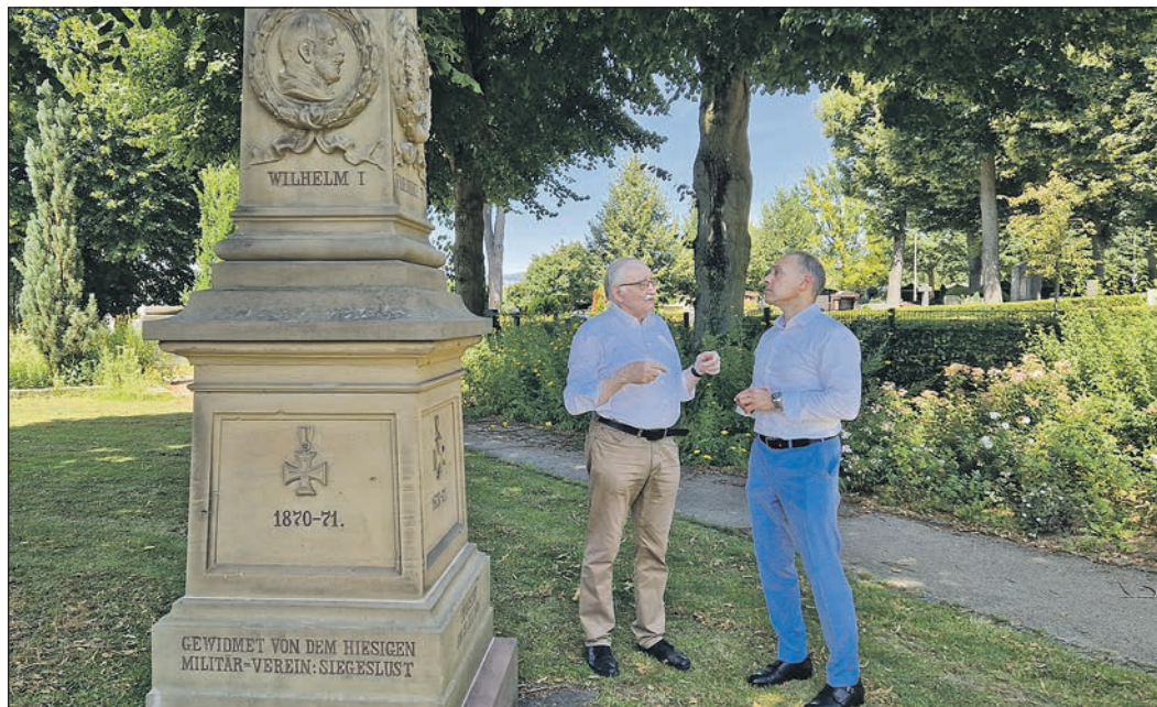
Bürgermeister Adnan Shaikh (r.) besichtigt mit Gerhard Raiss das renovierte Kriegerdenkmal am Friedhof. Foto: Stadt Eschborn
