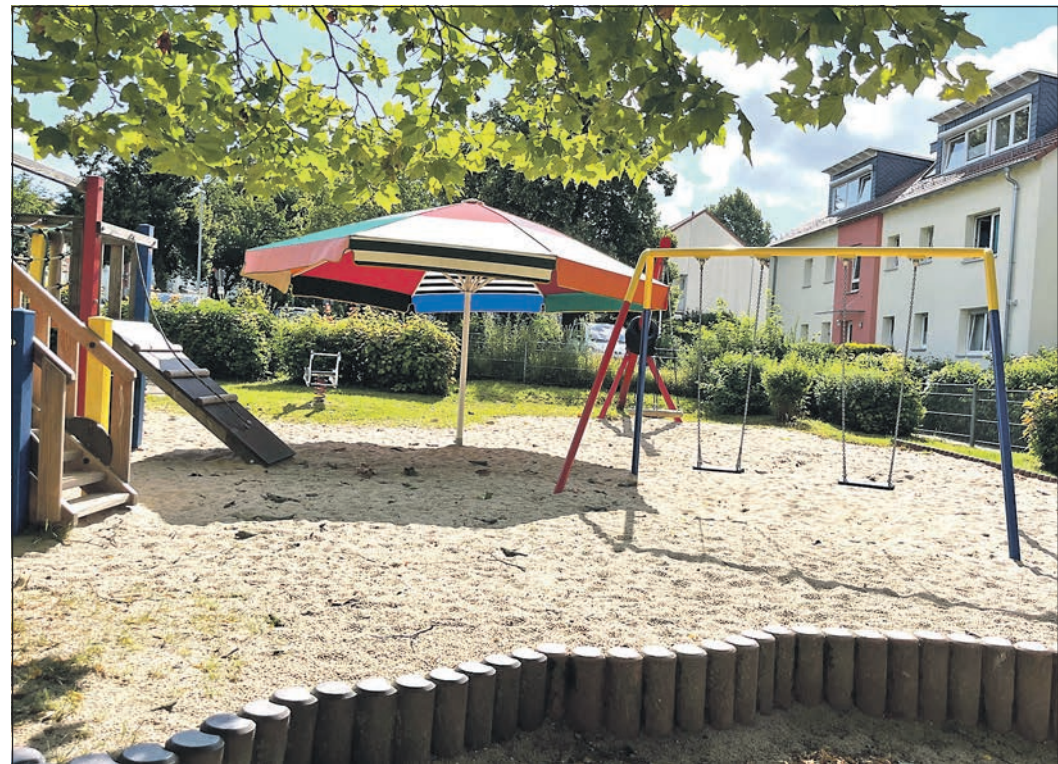
Eine neue Wasserpumpe ist auf dem Spielplatz Niederhöchstädter Pfad eingebaut worden, sodass den Kindern die Wasserspiele wieder viel Spaß machen. Foto: Stadt Schwalbach
