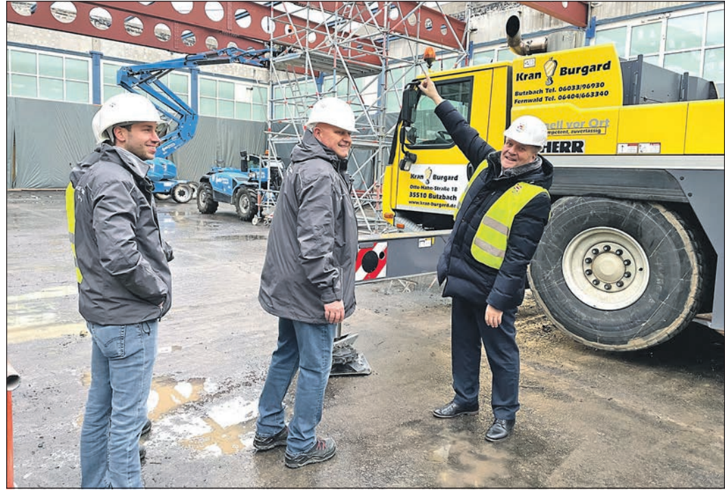
Die Sanierung der Sporthallendächer läuft bereits auf Hochtouren. Foto: Hochtaunuskreis
