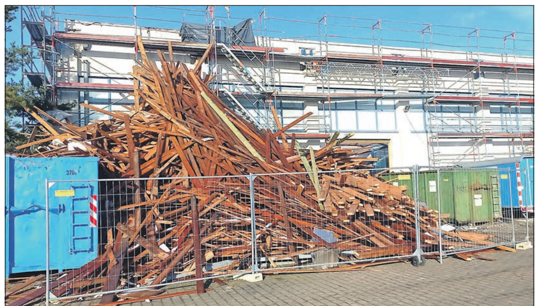
Von hier schaut man auf den Gesamtkomplex, er ist inzwischen komplett eingerüstet. Das abgetragene Dachgebälk wartet auf Abholung, es geht nur langsam voran. Foto: js
