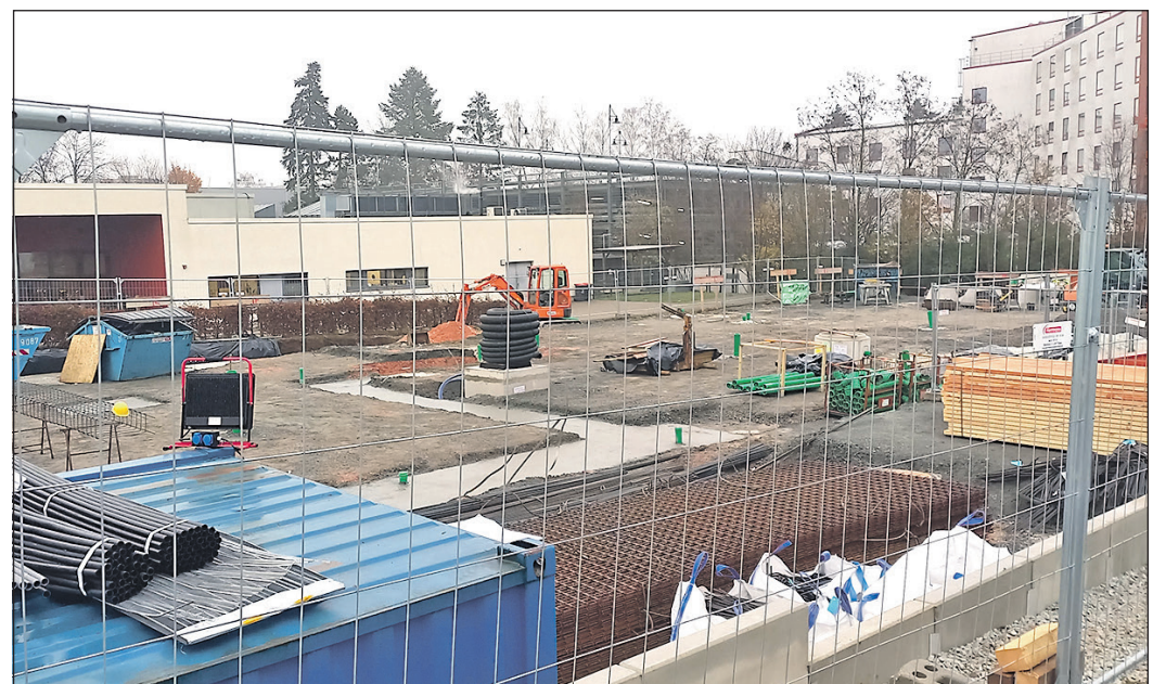
Auf der Baustelle zum Bau der DRK-Rettungswache.
