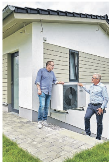
Rund 70 Prozent der Wohngebäude in Deutschland eignen sich ohne größere Umbauten für eine Wärmepumpe. Foto: DJD/Vaillant/ Bernd Gabriel
