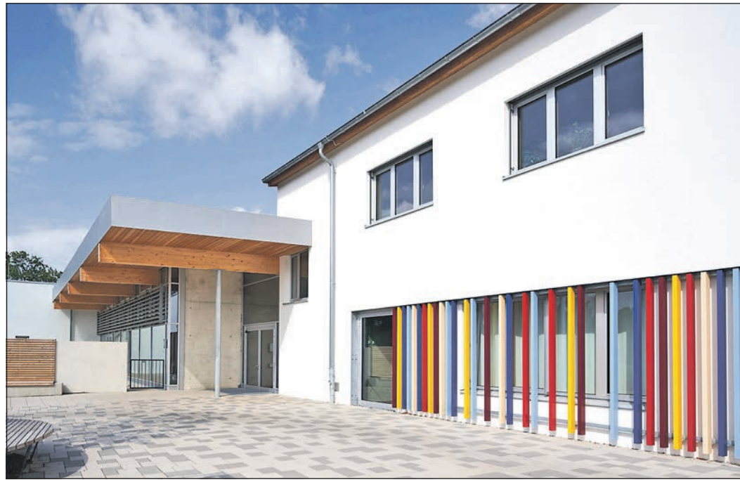
Auch der Erweiterungsbau der Hans-Magiera-Schule in der Straße Im Portugall 15 in Oberursel findet sich im Booklet des Tags der Architektur. Foto: Thomas Brenner
