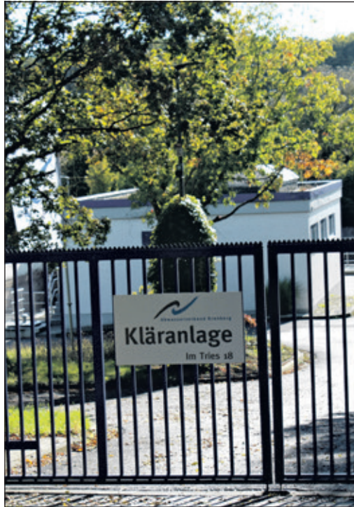
Die Kläranlage „Im Tries“ Foto: Puck
