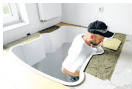
Nach 48 Stunden ist die Installation in der Regel abgeschlossen und der private Aufzug kann genutzt werden. (Foto: epr/Lifton/Bernd Lehnert)
