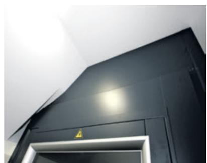
Der Aufzugschacht wurde von den Monteuren an die Dachschräge im Obergeschoss exakt angepasst. Zudem wurden im Erdgeschoss die Treppenstufen millimetergenau gekürzt, damit sich die Haustüre problemlos weit genug öffnen lässt.
