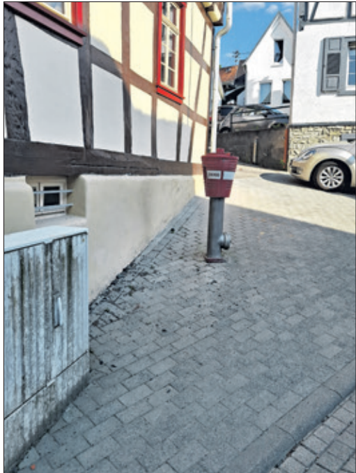
Hydrant am Alten Rathaus Falkenstein
