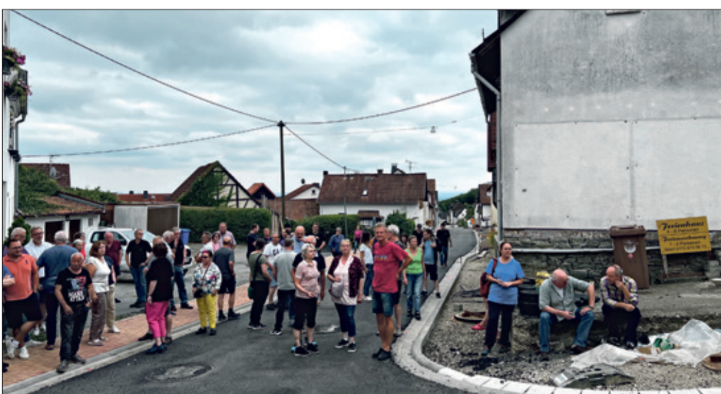
Dieser Blick die Robert-Koch-Straße runter lässt erahnen, was noch alles getan werden muss – und das ist der 2. Bauabschnitt.
