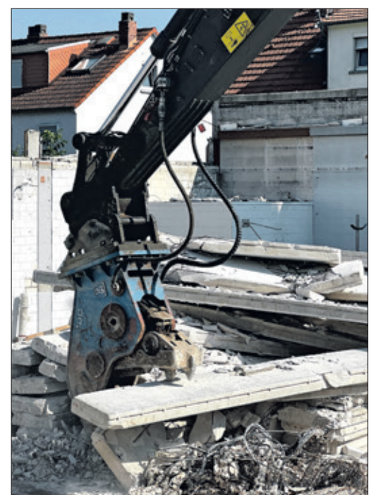
Der Greifer zerkleinert die Betonplatten und „filtert“ den Stahl heraus.
