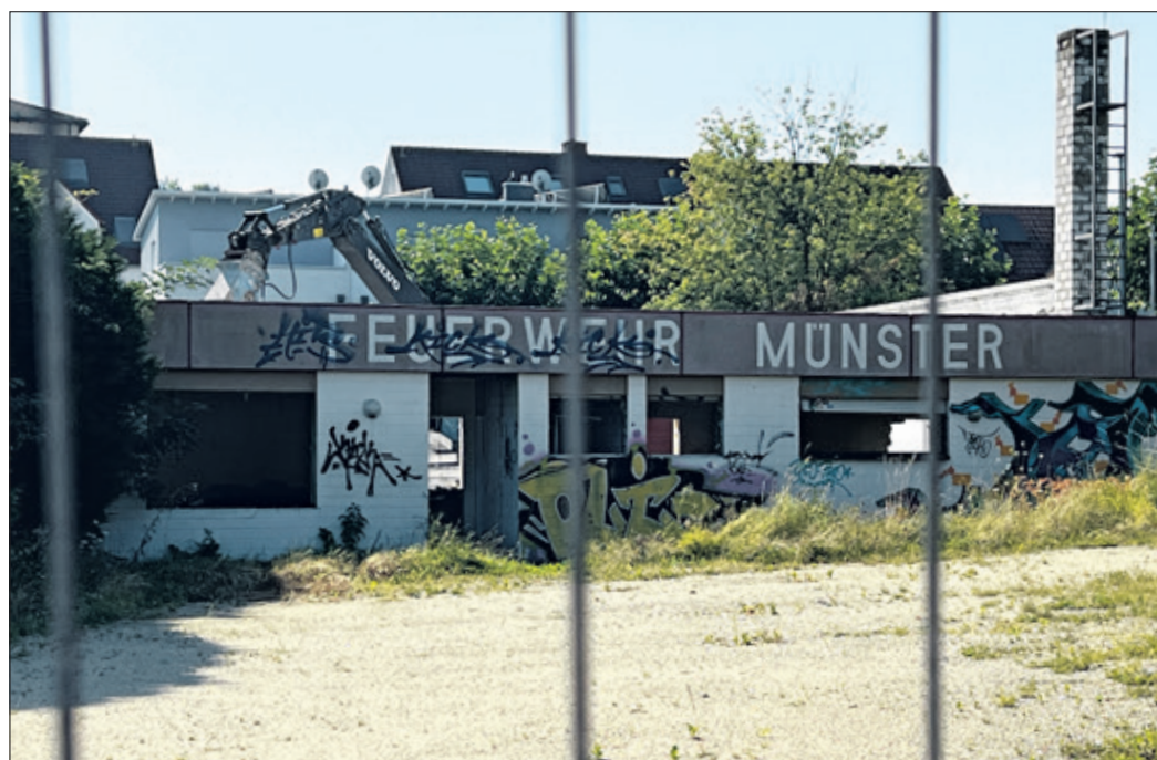
Ein letzter Blick durch den Bauzaun auf die ehemalige Feuerwehr Münster.
