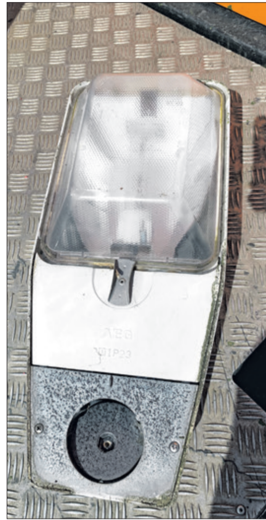
Das kann weg: Die alten Laternen werden auseinandermontiert und entsorgt.
