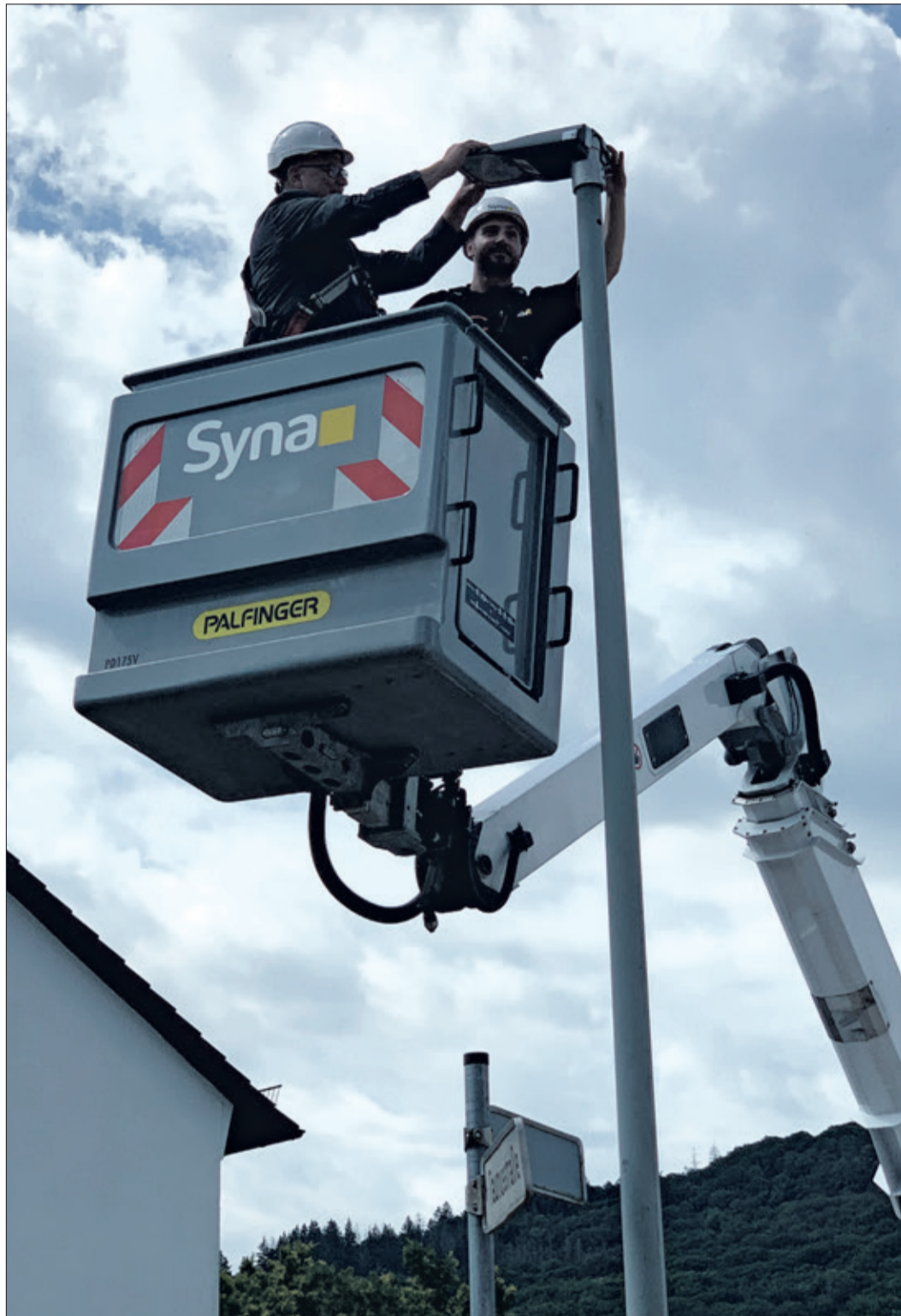
Ein Bürgermeister in luftiger Höhe als Hiwi beim Austausch der Leuchten.
