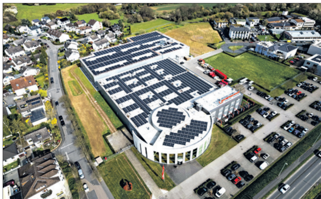
Das ROTHENBERGER TEC Center nach dem Neubau. Die neue Fertigungshalle (hinten) schafft Platz für die Produktionserweiterung (+4.400m 2 ) und neue Arbeitsplätze, inklusive einer verdoppelten Ausbildungswerkstatt. Die Fotovoltaikanlage auf dem TEC Center hat eine Leistung von 1.000 kWp. Foto: Rothenberger
