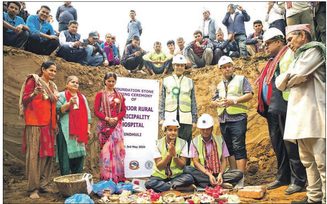
Feierlich wird der Grundstein für das neue Krankenhaus im Osten Nepals gelegt. Die Einrichtung wird die medizinische Versorgung von über 36 500 Menschen in einer der ärmsten Regionen des Landes sicherstellen. Foto: Back to Life
