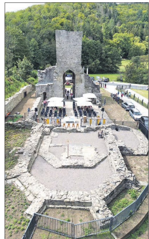
So sieht die sanierte Kirche aus der Vogelperspektive aus. Foto: Hochtaunuskreis
