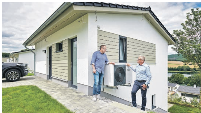
Rund 70 Prozent der Wohngebäude in Deutschland eignen sich ohne größere Umbauten für eine Wärmepumpe. Foto: DJD/Vaillant/Bernd Gabriel
