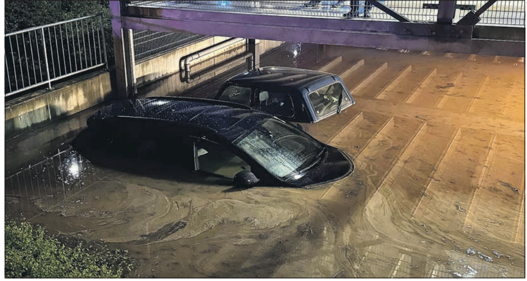
Auch die Hochtaunus-Kliniken in Bad Homburg sind vom Unwetter betroffen. Hier ist Wasser in die Tiefgarage eingedrungen. Mehrere Autos werden beschädigt. Foto: HTK
