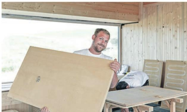
Den Einbau einer energiesparenden und wohlbefähiglichen Deckenheizung mit Lehmputz-Trockenbauplatten können versierte Heimwerker selbst in die Hand nehmen. Foto: DJD/Naturbo
