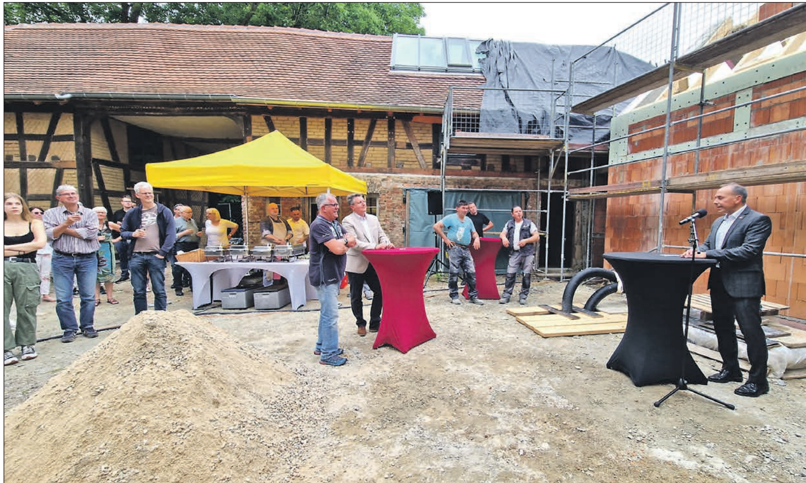
Beim Richtfest der Erweiterungsbauten der Alten Mühle spricht Bürgermeister Adnan Shaikh lobende Worte und dankt allen Projektbeteiligten für die gute Arbeit. Foto: Stadt Eschborn
