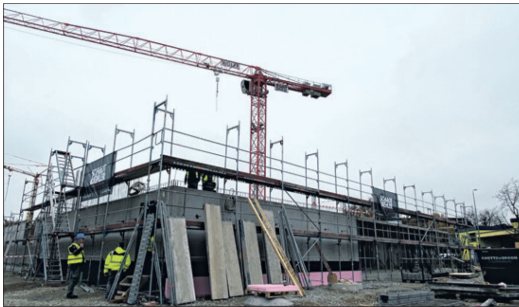
Die Baustelle nimmt Gestalt an – 2025 soll die neue Feuerwache fertiggestellt sein.
