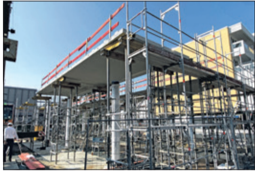
Die Gesamtkonstruktion der Bussteige mutet erstaunlich filigran an. Foto: Scholl
