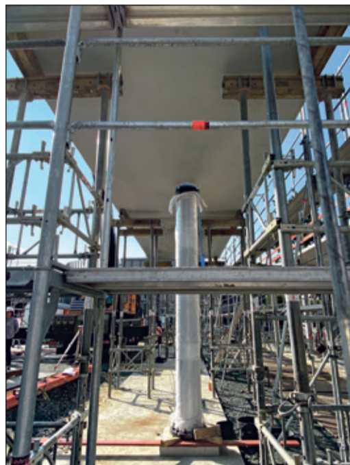
Verwirrend und gleichzeitig interessant: das Gerüst rund um die neuen Bussteige.
