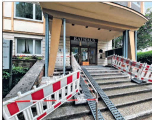
Vier Stahlträger übernehmen die Stützfunktion. Foto: Stadt Bad Soden
