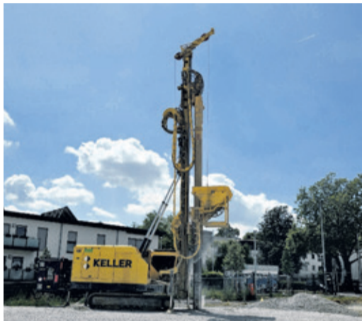
An der Baustelle der neuen Feuerwache: So sieht das imposante Baugerät aus.
