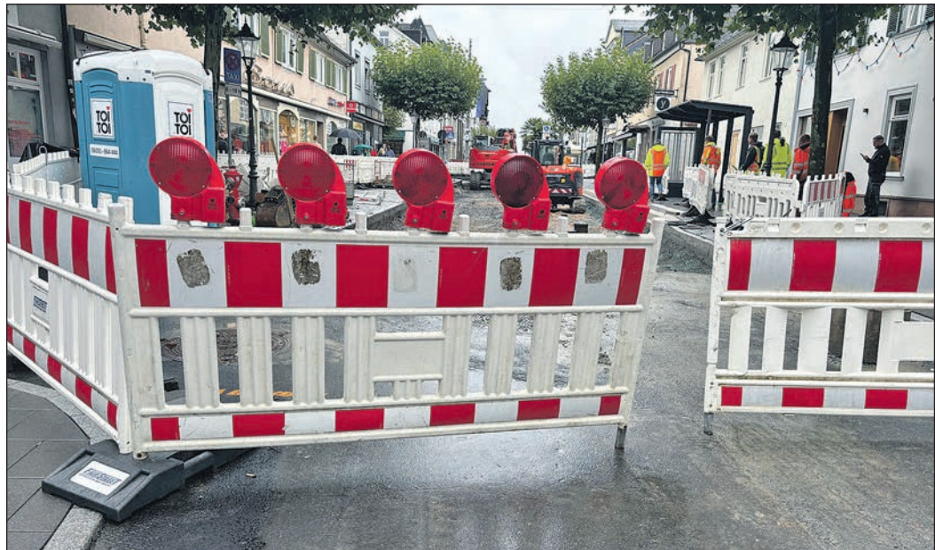
Sobald die Asphaltdecke ausgehärtet ist, kann die Straße wieder befahren werden – das soll voraussichtlich am Ende der Herbstferien der Fall sein. Foto: Stadt Bad Homburg
