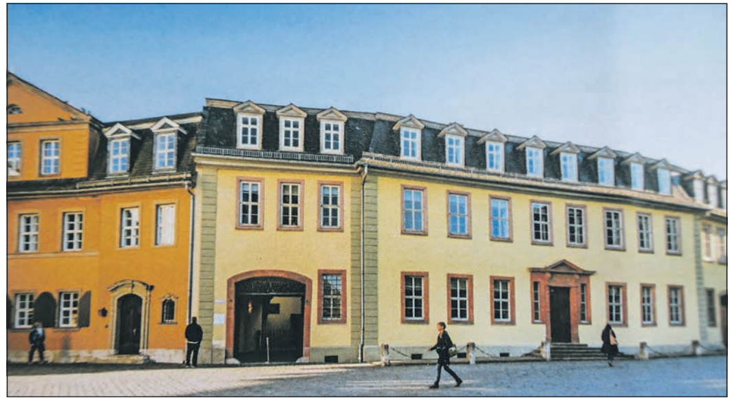
Die Sanierung von Goethes ehemaligem Wohnhaus in Weimar steht wegen der Rücknahme staatlich zugesagter Fördergelder akut in Frage. Repro: a.ber
