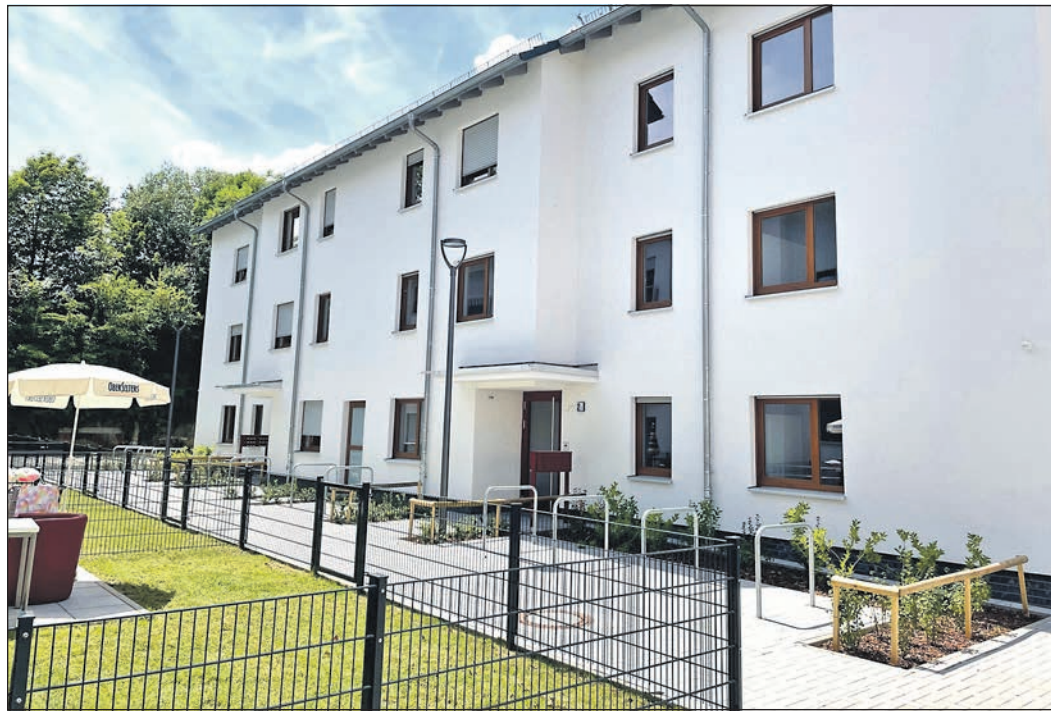
Im Erlenweg sind pro Gebäude zwölf Wohnungen entstanden, von denen jeweils zwei im Erdgeschoss gelegene barrierefrei sind. Foto: Stadt Bad Homburg
