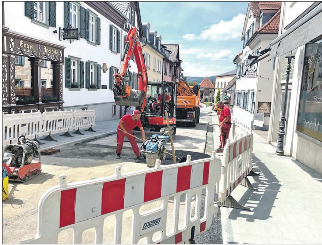
Aktuell sind die Arbeiter der Straßenbaufirma Schütz auf dem Abschnitt Schulberg im Einsatz. Auch dort wurden die Gehwege bereits gepflastert und weisen künftig eine Breite von etwa zweieinhalb Metern auf. Foto: Stadt
